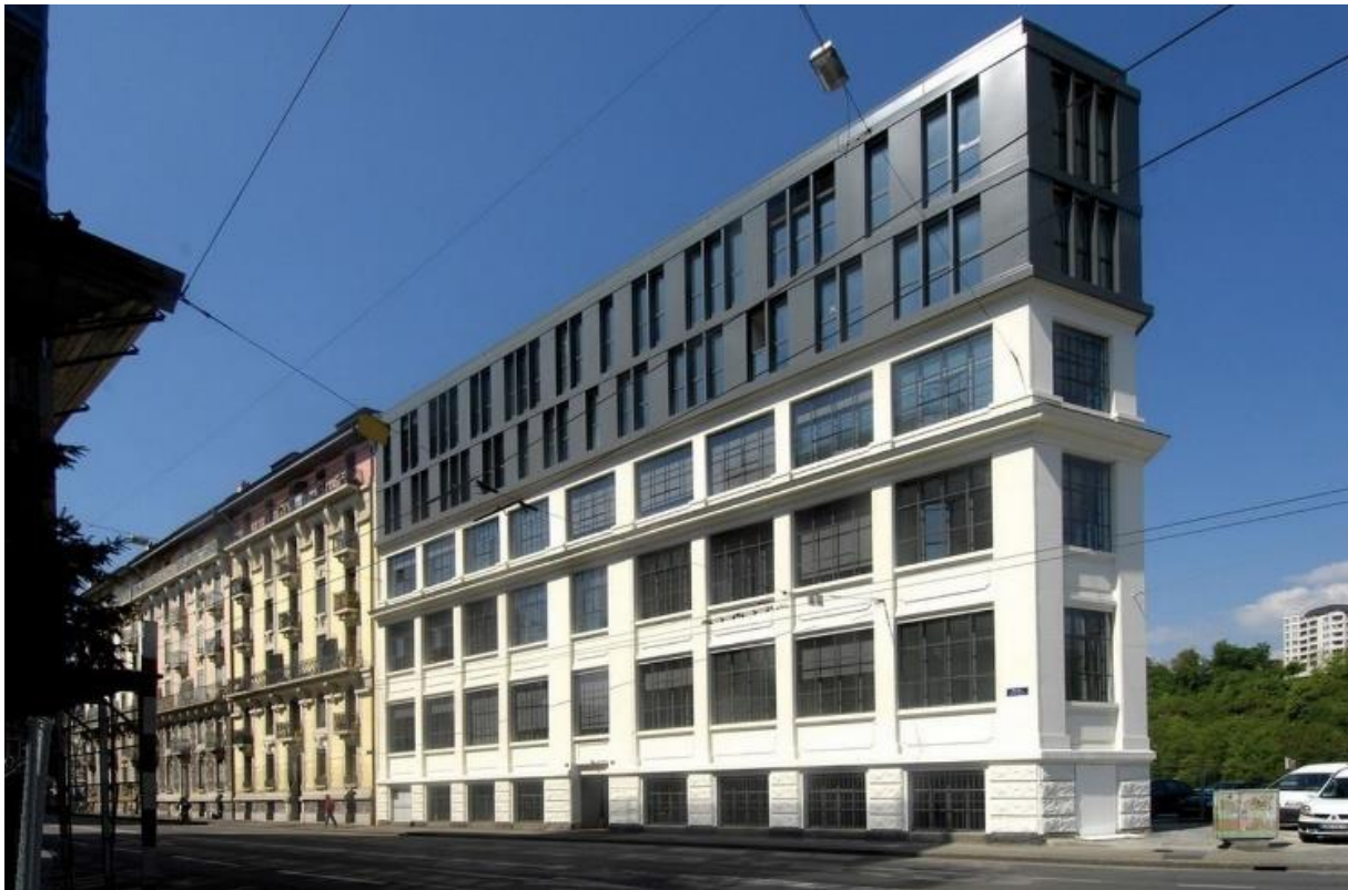
Surélévation de la résidence sociale des Berges du Rhône, Genève
